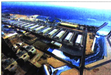
Рис. 70. Завод по опреснению морской воды
