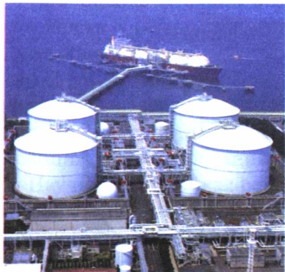
Рис. 16. Резервуары для хранения сжиженного природного газа
