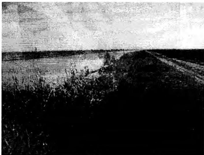
5.2 - rasm. Kanal qirg'og'ini o't bosish holati
