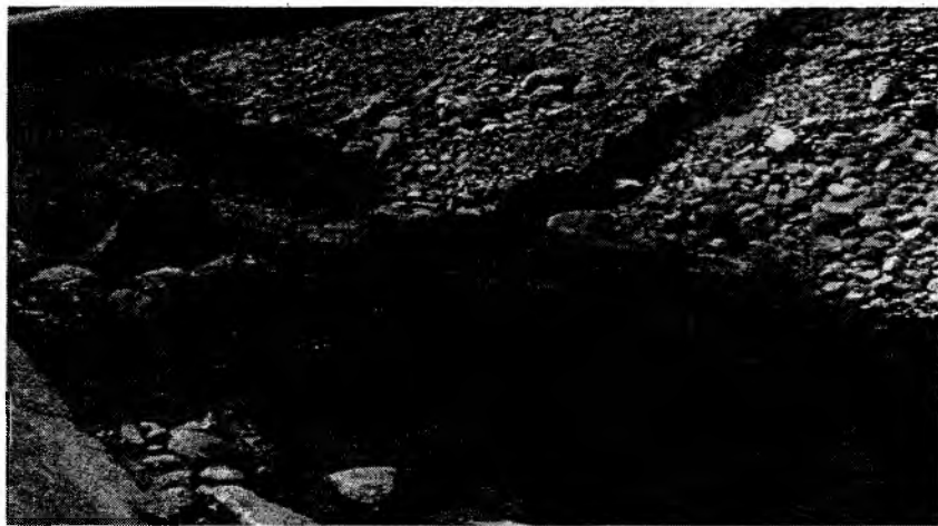
5.11 – rasm. Tog' yon-bag'ridan o'tgan kanal o'zanini tosh bosishi holati.
