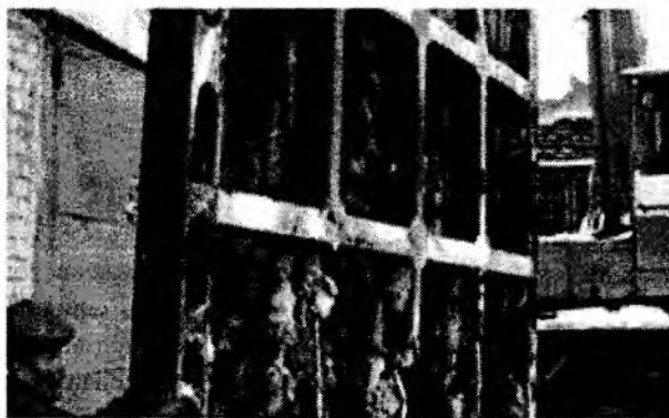
3.3 - rasm. Do'stlik kanalini PK 260 va PK 580 da joylashgan gidrouzellarga o'rnatilgan zatvorlarda yuz bergan karroziya xodisasi
