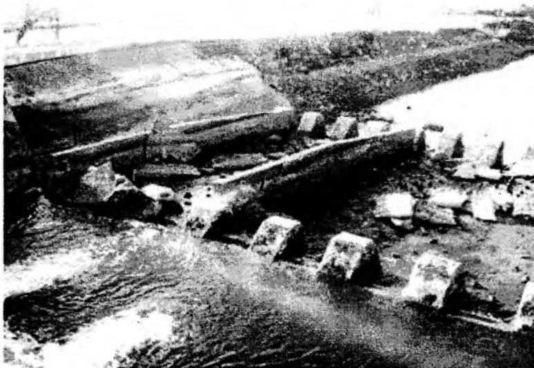
3.2 - rasm. Do'stlik kanalining PK 580 da joylashgan tashlama inshootni pastki b'efidagi abraziv emirilishlar
