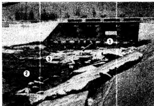
15.1 - rasm. Chap qirg'oq Qorasuv kanali 9+20 pikeidagi suv taqsimlash inshootining Qorasuv daryosiga suv tashlamasi pastki befini ko'rinishi: 1 - pirlar; 2 - yuvilish daganagi; 3 - fundament bloklari.
