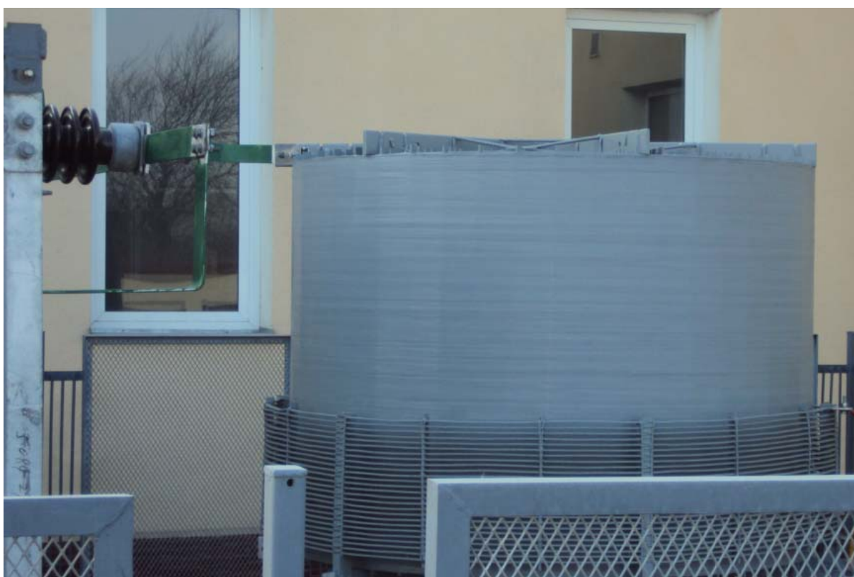
72-rasm. Polimer izolyatsiyali reaktor.
