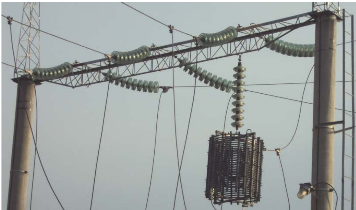
71-rasm. Atmosferadagi osma 110 kV reaktor.
